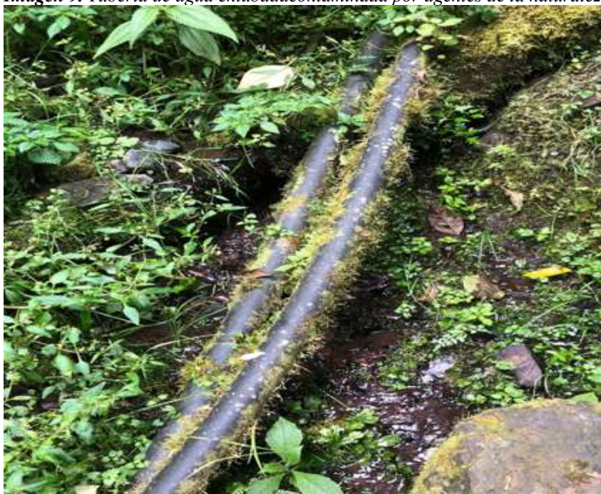
Imagen 9. Tubería de agua entubada contaminada por agentes de la naturaleza
