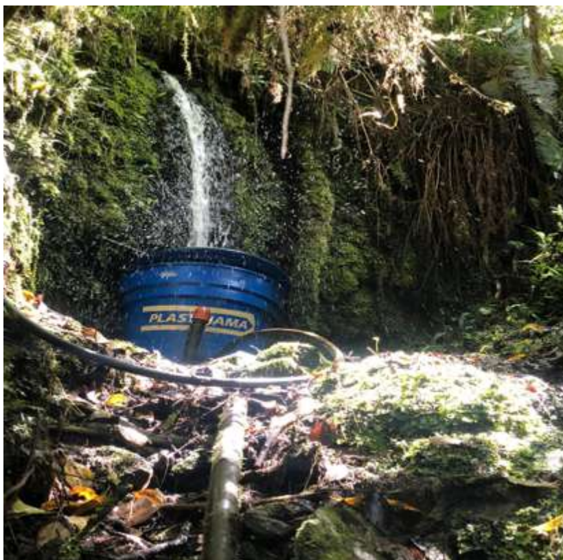
Imagen 4. Tanque de captación vertiente El Sigse, expuesto a los embates de la naturaleza
